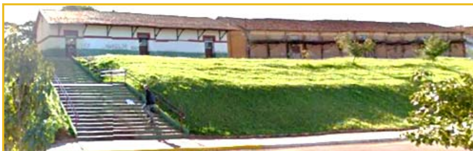
Figura 7 – O galpão de depósito do conjunto ferroviário, 2014.
